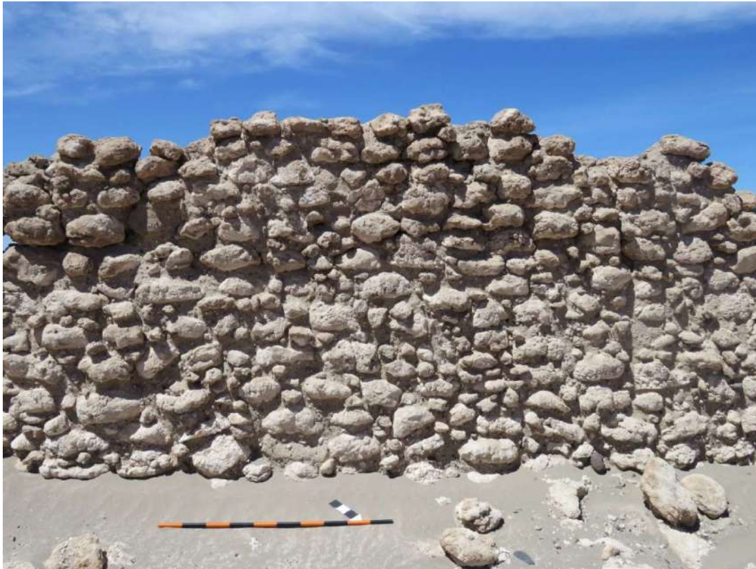
Detalle de un muro de la Aldea Caserones construido con anhidrita o caliche local
