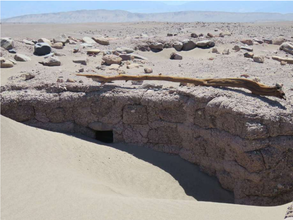
Detalle del mismo recinto de la lámina anterior, construido con bloques y mortero de barro. Semi sepultado se observa un vano.
