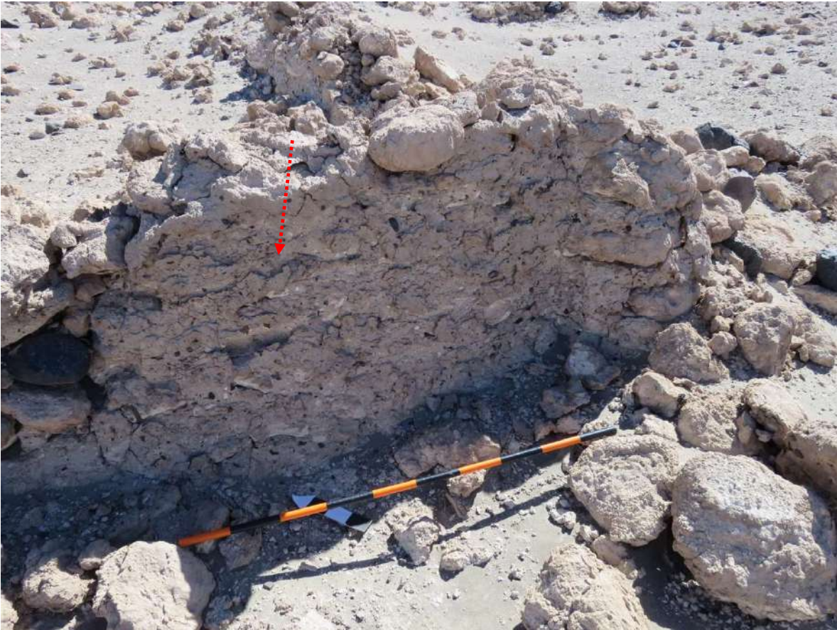
Desprendimiento de revoque en el muro.
