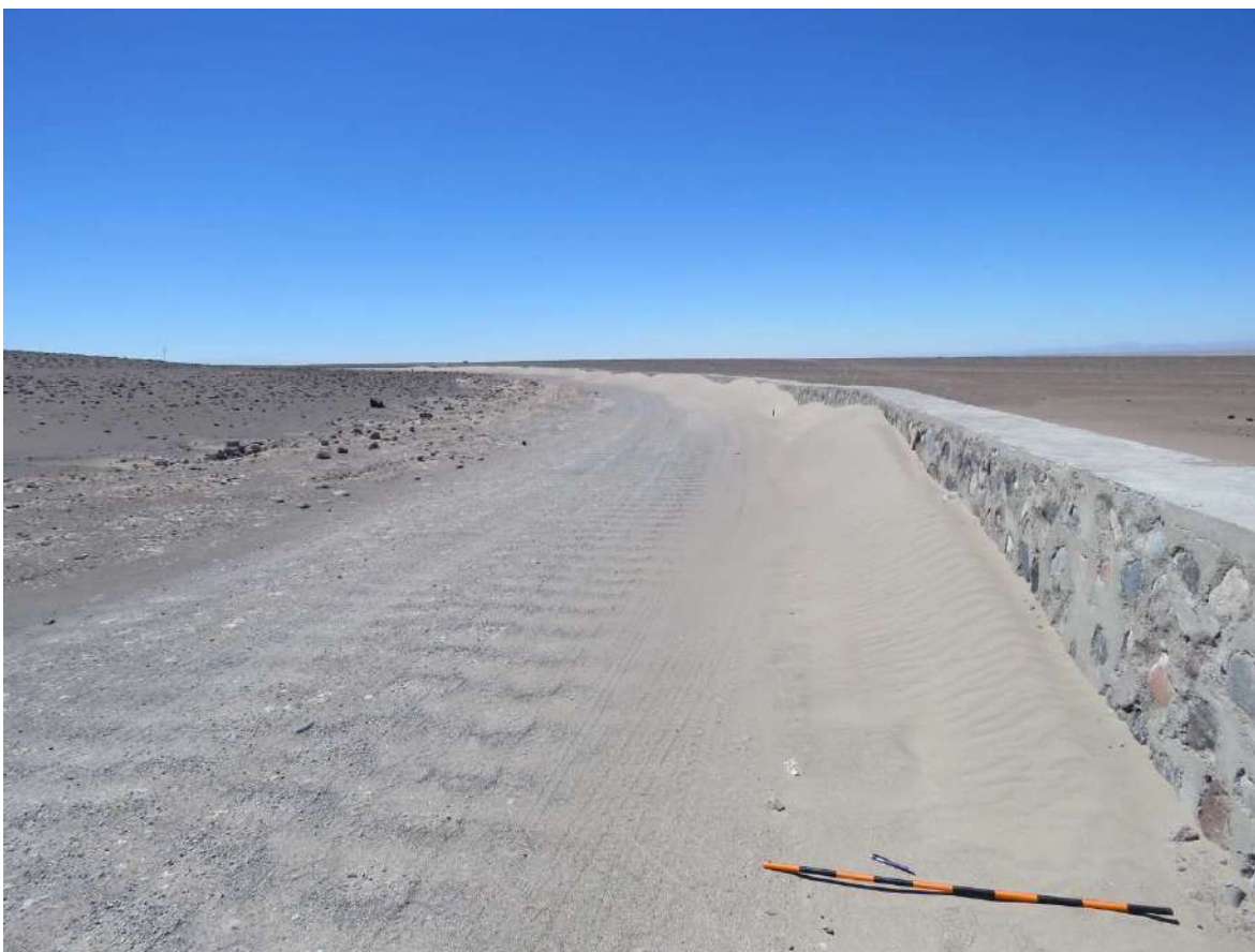
Deposición de arena en muros del abandonado e inconcluso cierre perimetral.
