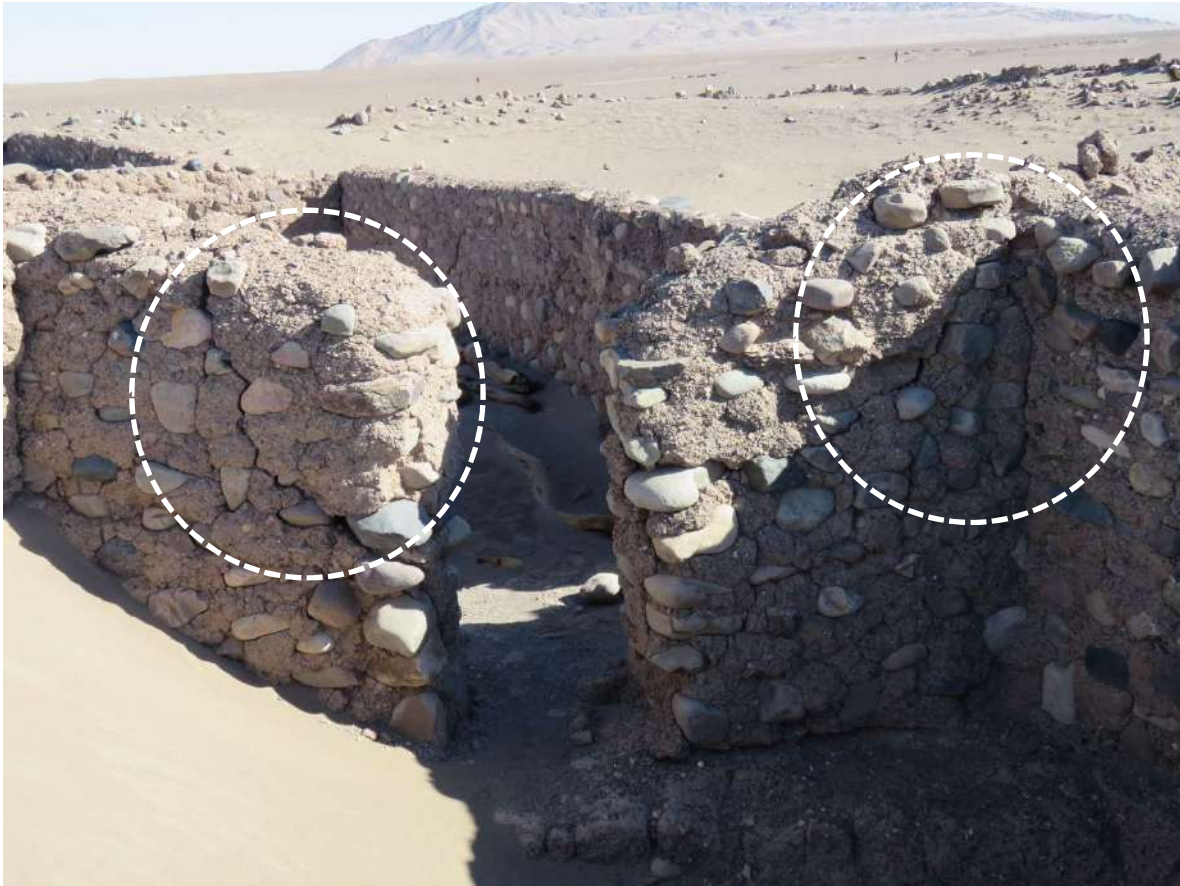
Recinto 4: Vista (a). Vano con severas fracturas a ambos lados del muro oeste y este. Imagen tomada desde el interior del recinto. Las maderas que se observan en la imagen corresponden al recinto 3.
