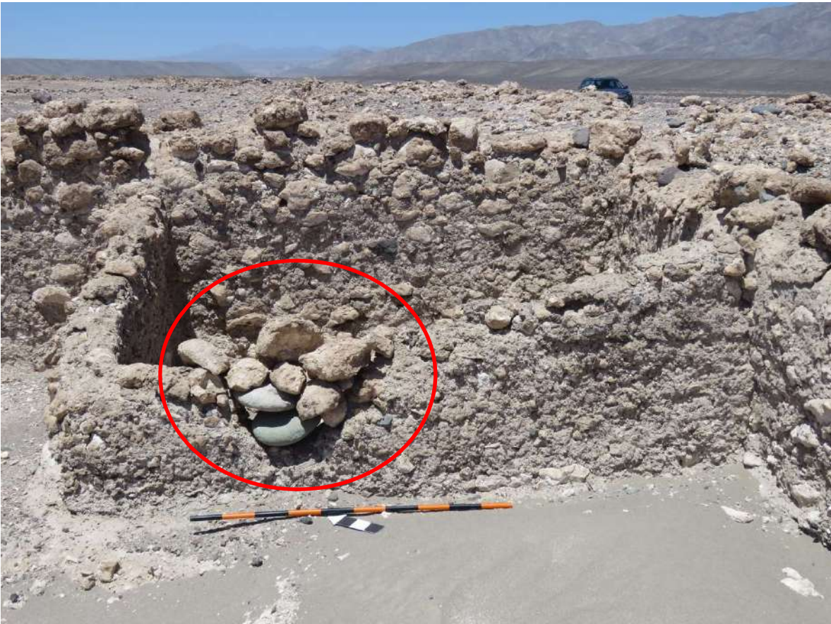
Muro del recinto 359 con intervención posterior.
