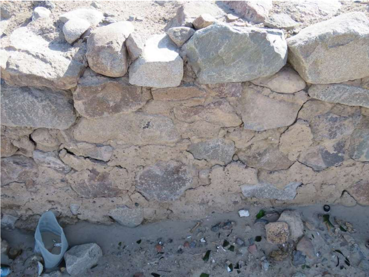
Detalle de muro con aparejo sedimentado. Presenta grietas y desprendimiento de argamasa de barro.
