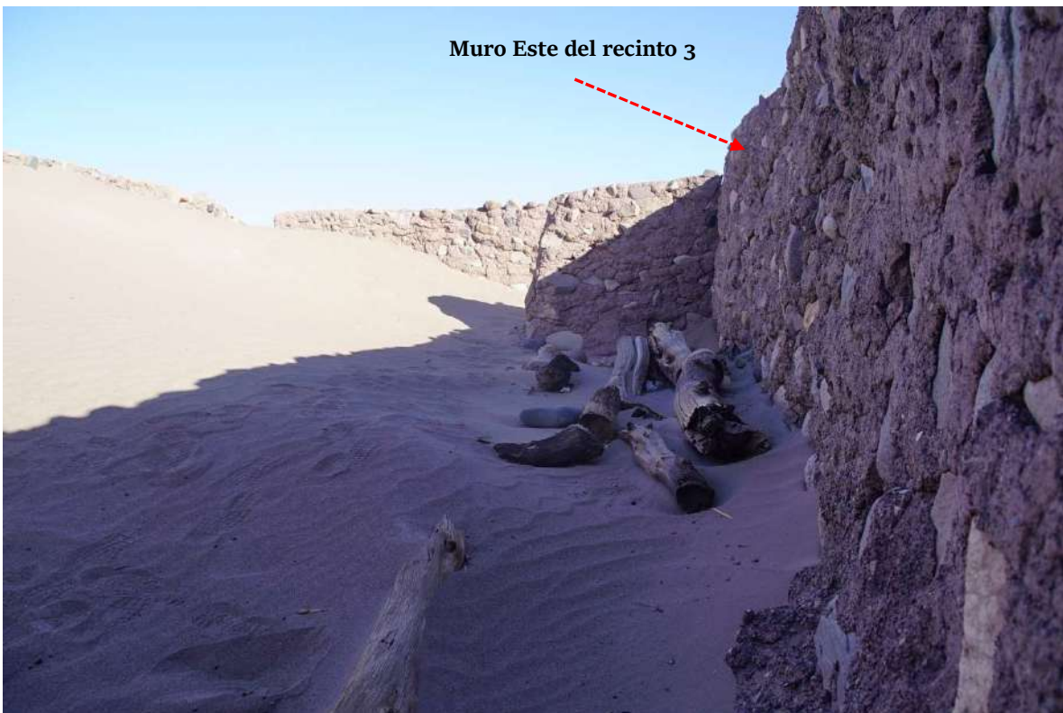
Recinto 3 del muro este. Se observan los troncos despojados de su lugar original.
