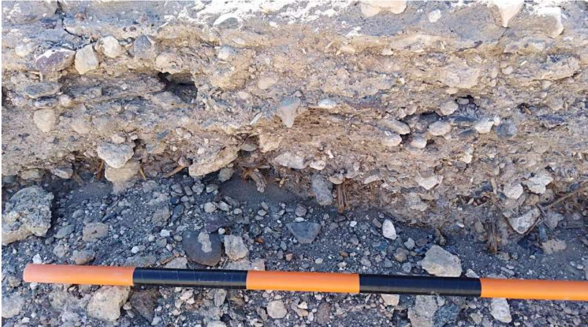
Detalle de techumbre colapsada en el sector intramuros
