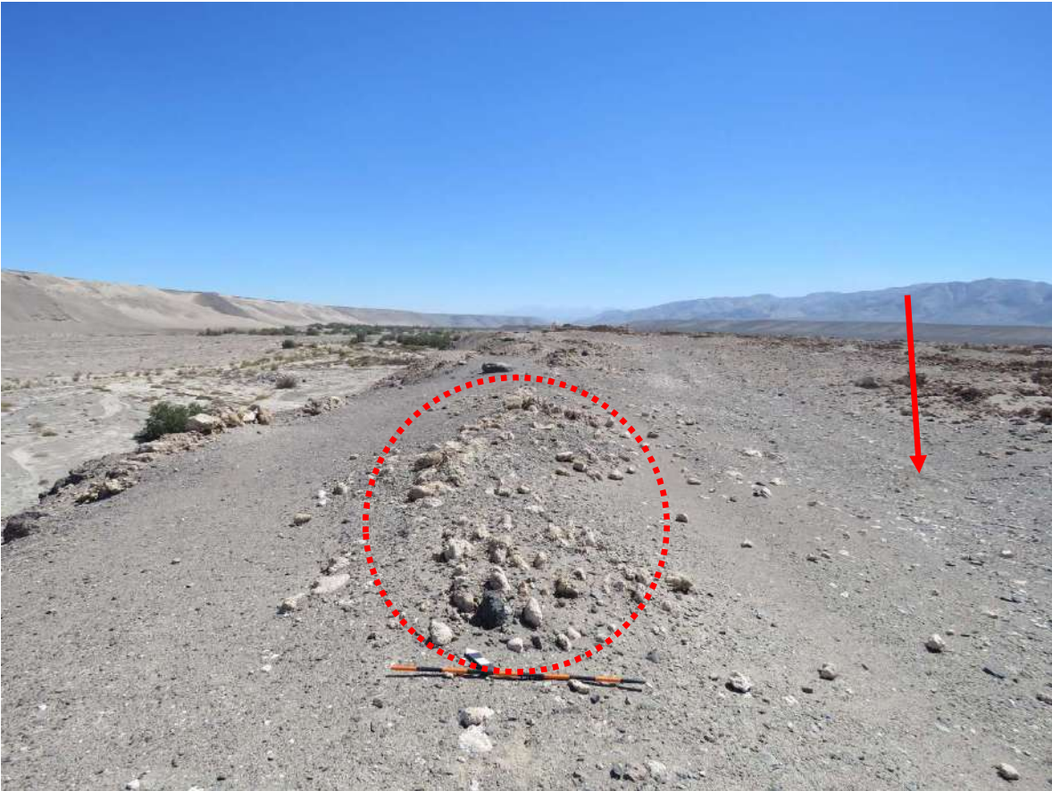
Muro perimetral noroeste derrumbado con tránsito vehicular al costado derecho de la imagen.
