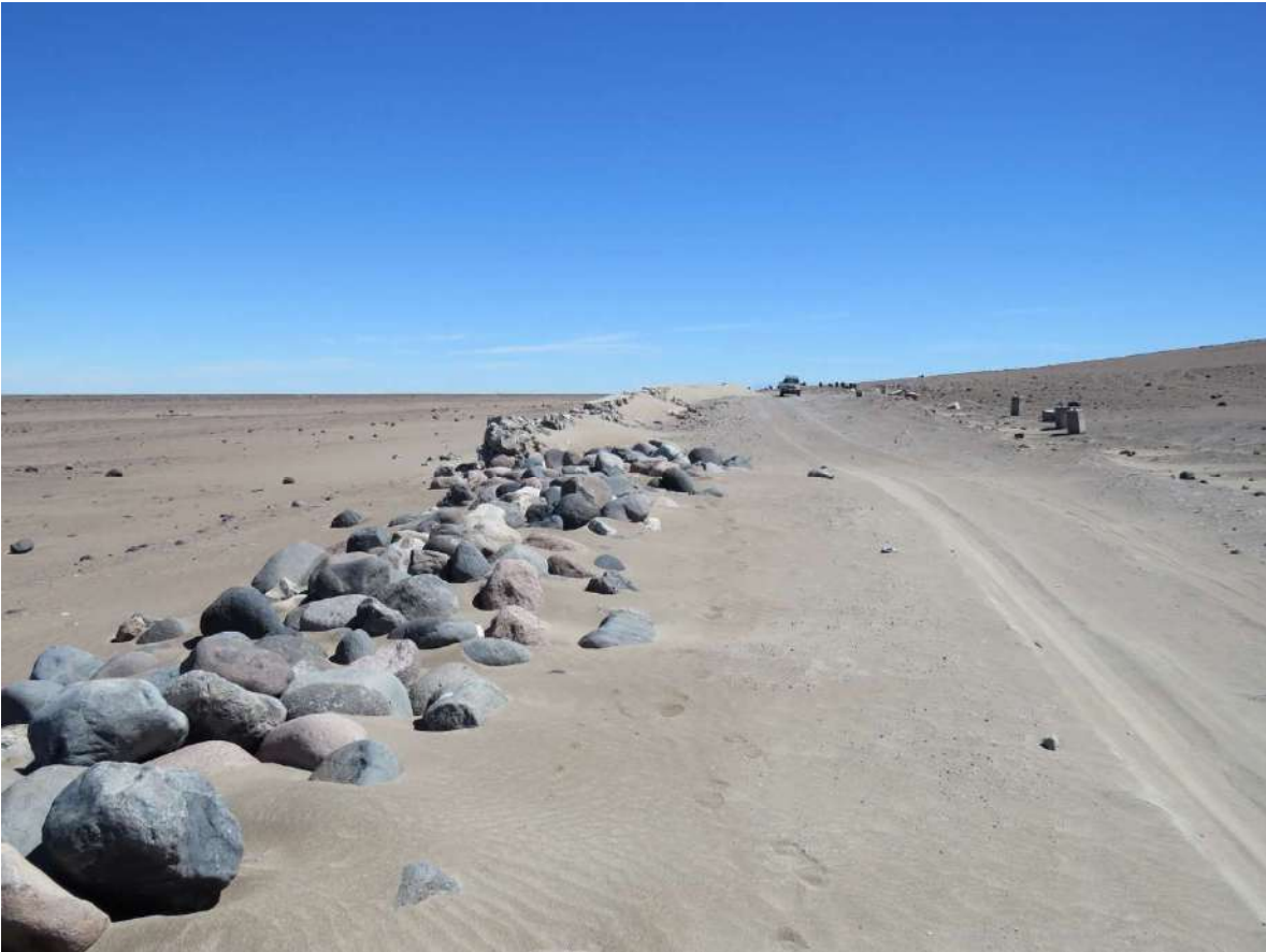
Otra vista del muro perimetral inconcluso y apilamiento de rocas para la confección del cierre.
