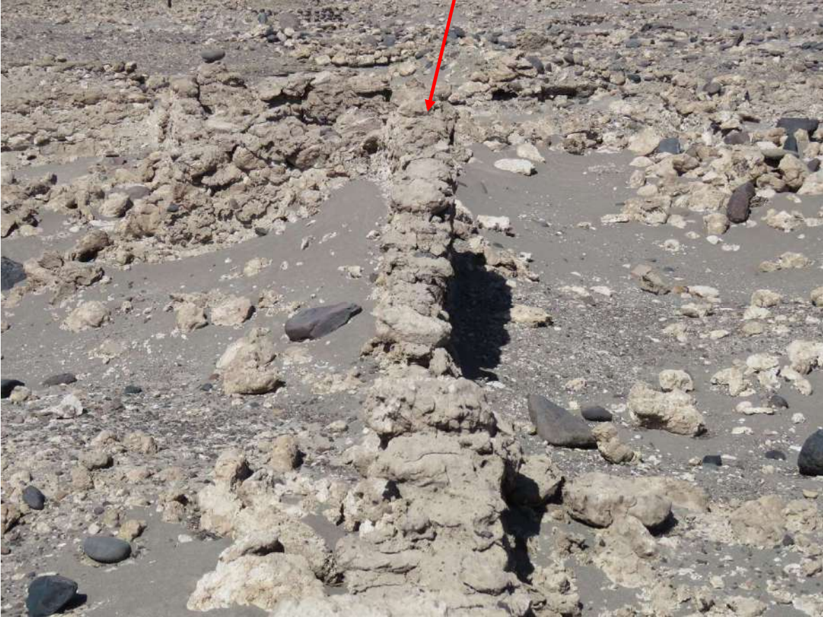
Detalle de un segmento de muro levemente inclinado o “desaplomado” debido a la presión que ejerce la depositación de arena sobre una de las caras del muro en el Conglomerado 3.
