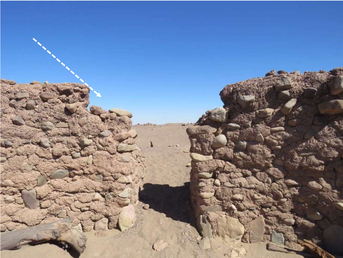
Recinto 5: Vista (c). Desprendimiento con faltante de muro en la parte superior del vano. muro Norte.
