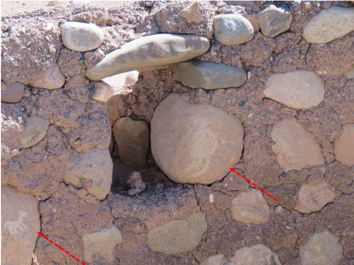
Recinto 17: Vista (c). Detalle del mismo vano con petroglifos. Nótese las fisuras entre las rocas y el mortero de barro.
