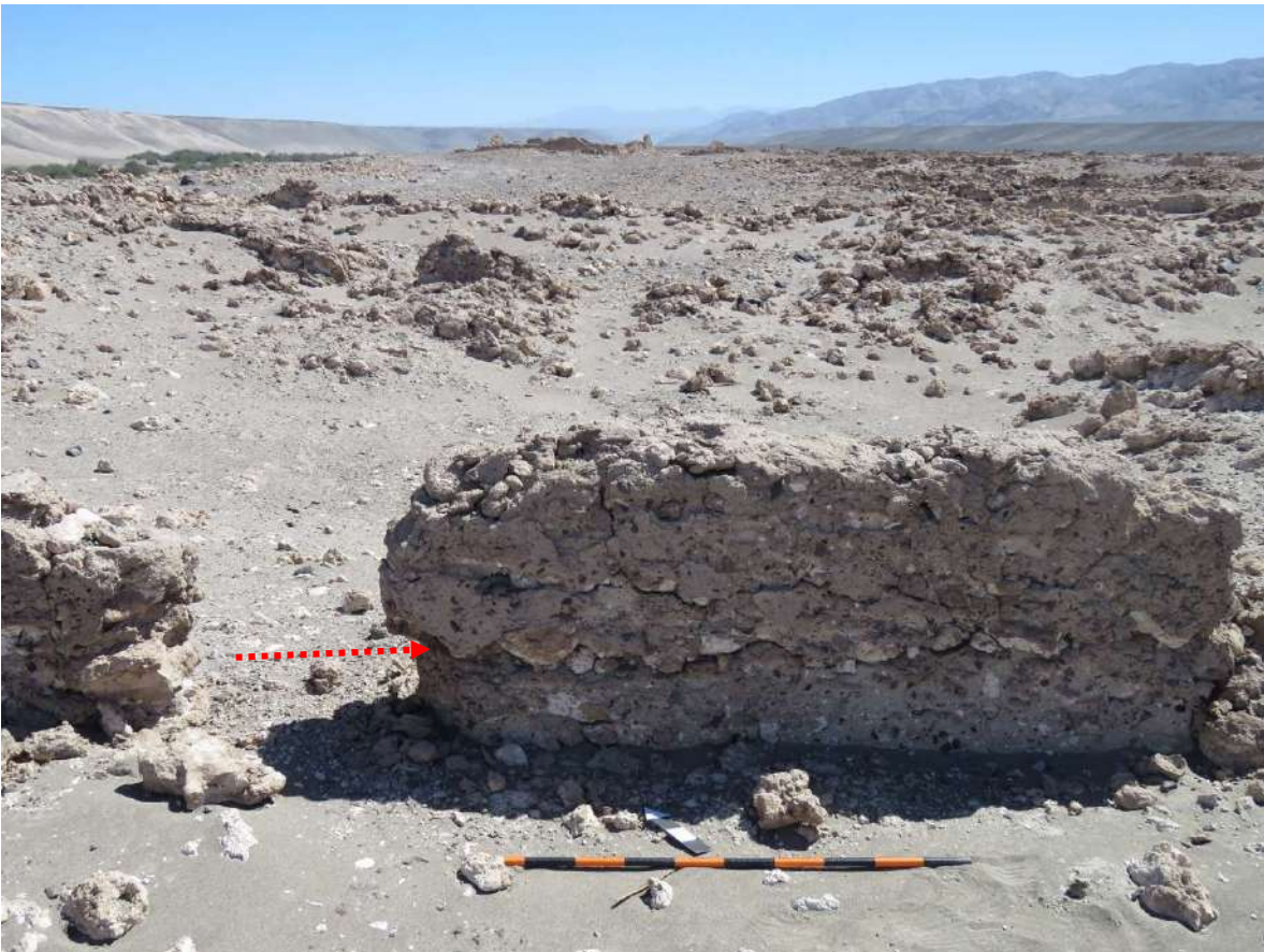
Fractura longitudinal de un segmento de un muro con restos de revoque.
