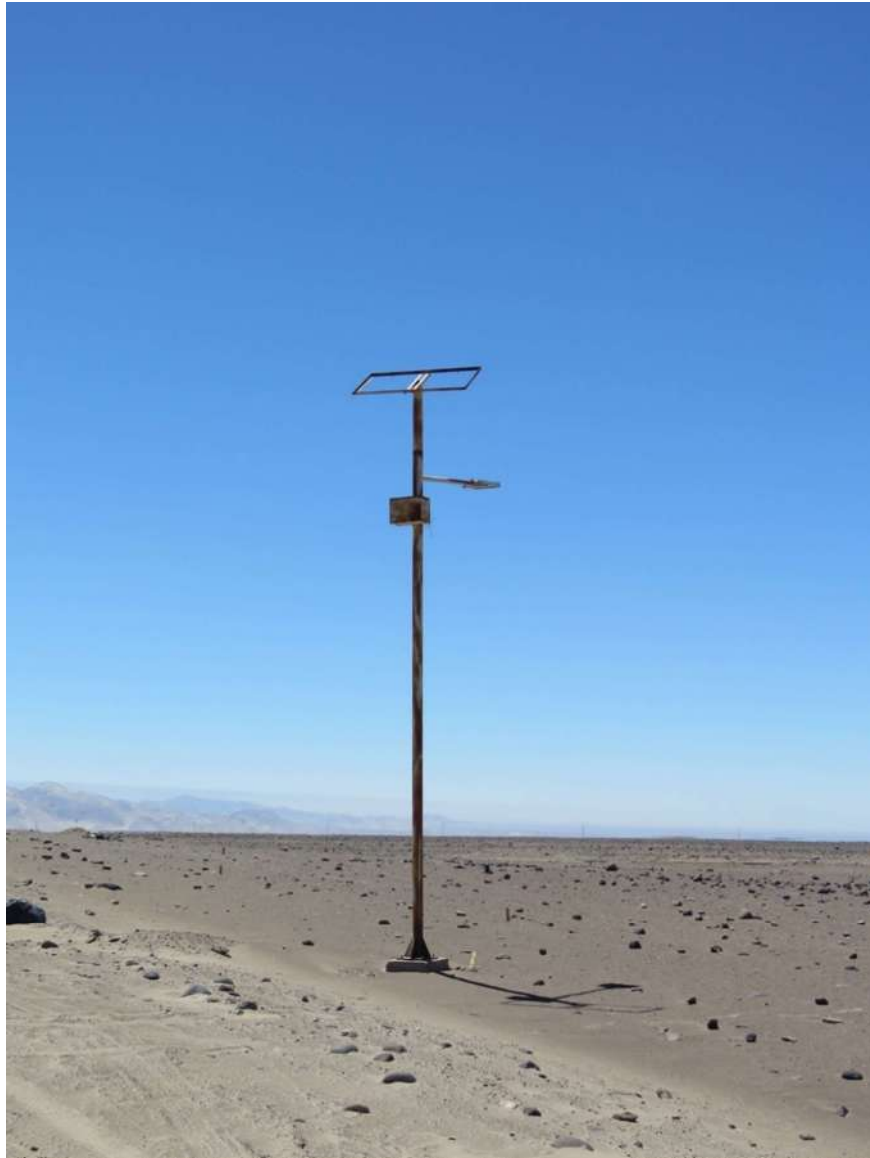
Alumbrado fotovoltaico en desuso.
