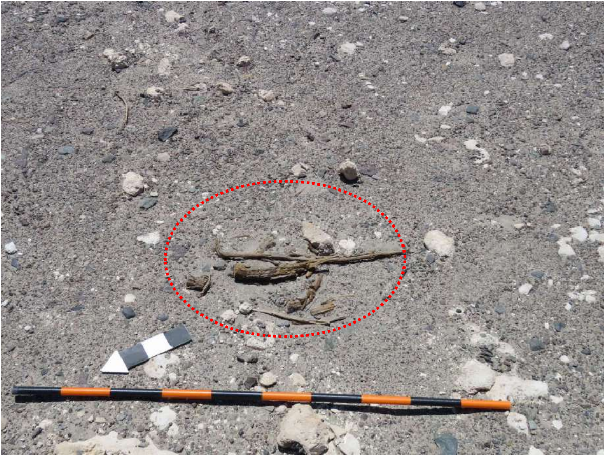
Restos de maderas en estado de friabilidad en muro perimetral.
