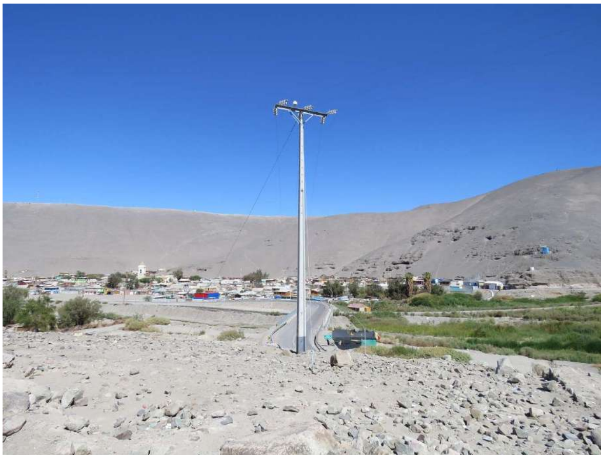
Registro de uno de los postes del tendido eléctrico en la sección alta del sitio.
