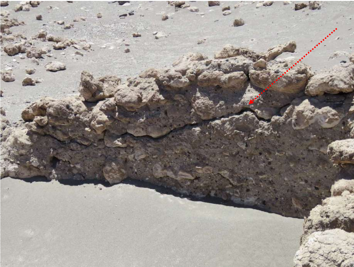
Fractura longitudinal oblicua en uno de los muros.
