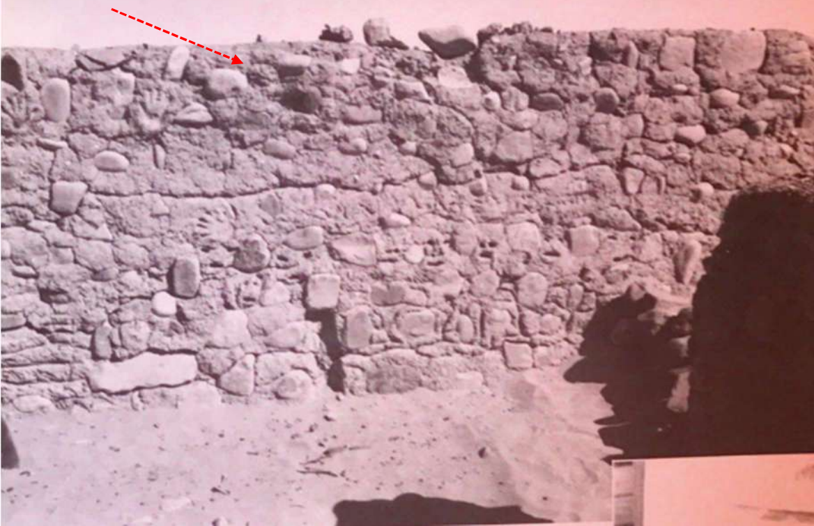
Imagen de detalle del muro Oeste del recinto 3 a la altura del acceso. Se observan improntas de manos y caras. Fuente: Rivera, 2013.
