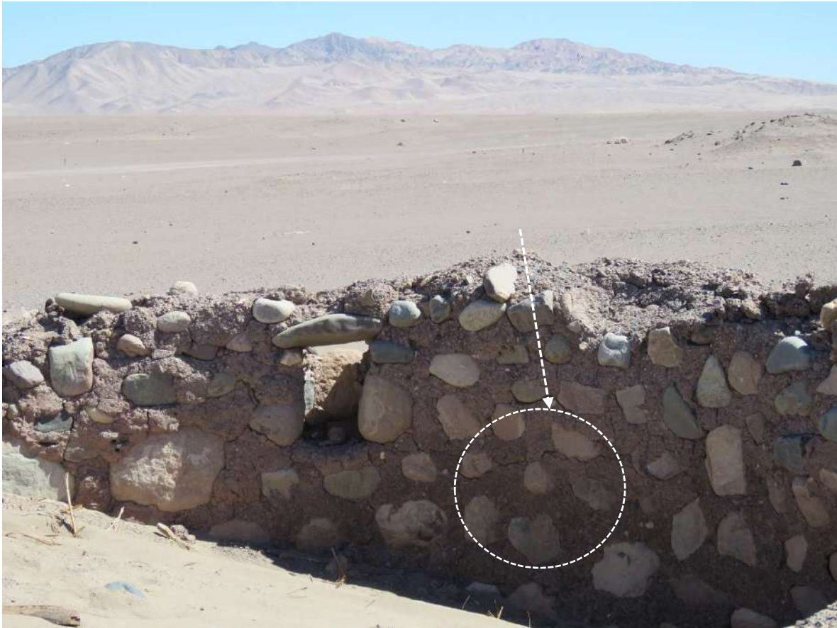
Recinto 17: Vista (b). Se observan grietas o fisuras menores en la estructura con vano y petroglifo sobre piedra arenisca en buen estado. Testigo de muro en regular a buen estado de preservación.
