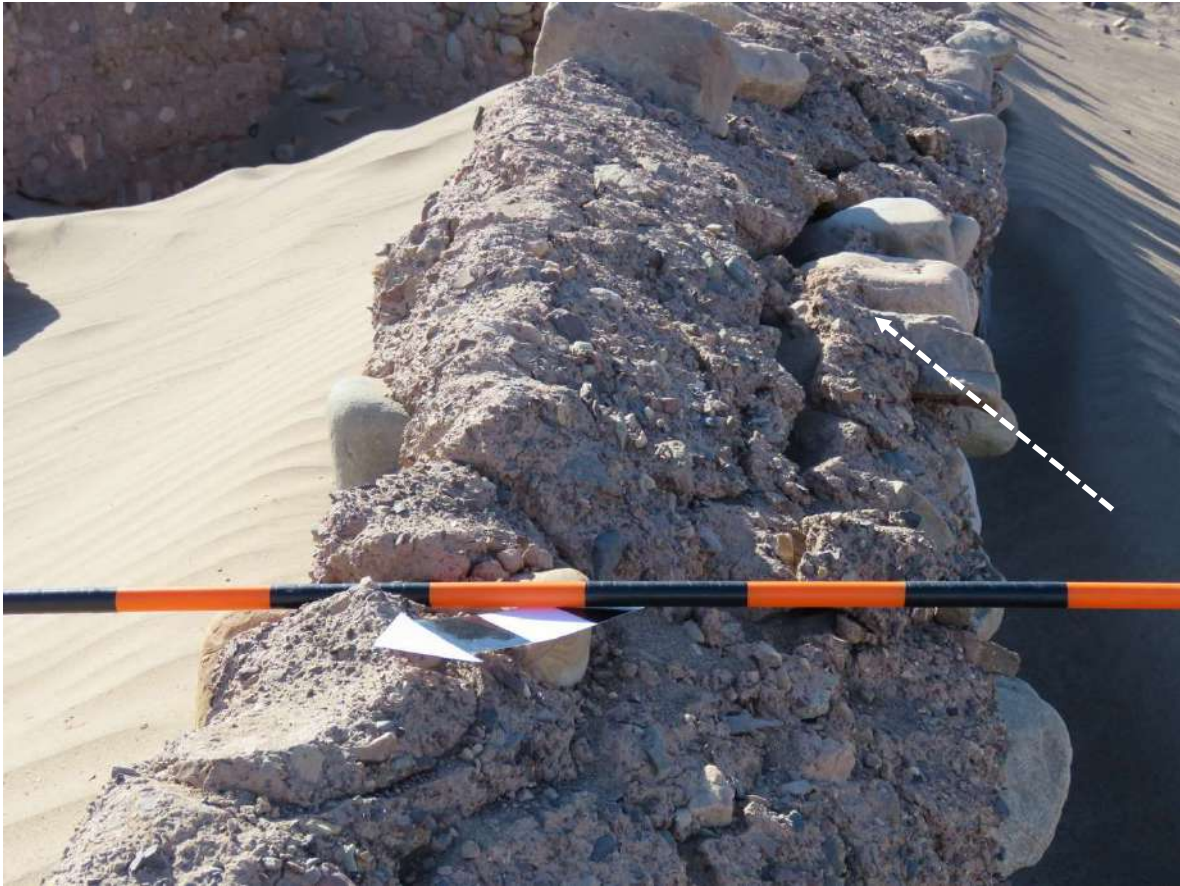
Recinto 2 y 3: Vista (b) del muro exterior oeste. Detalle de fractura profunda en la corona del muro con desprendimiento parcial de clastos.
