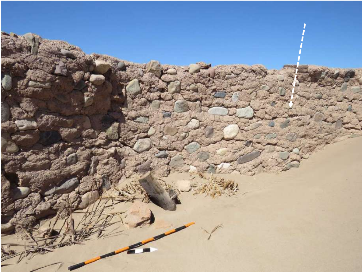
Recinto 3: Vista (a). Muro oeste en proceso de sepultación. Presenta buen estado de conservación, con algunas fisuras lineales y un faltante menor en la corona. Conserva la impronta de una cara grabada en la argamasa. Las demás improntas de carácter cultural en este muro actualmente están sepultadas con arena.
