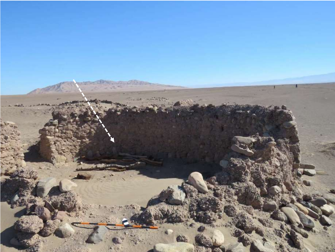
Acopio de troncos de los pilares del recinto 5 dejados después de la excavación. Estructura en regular estado de preservación en la sección superior del muro Oeste.
