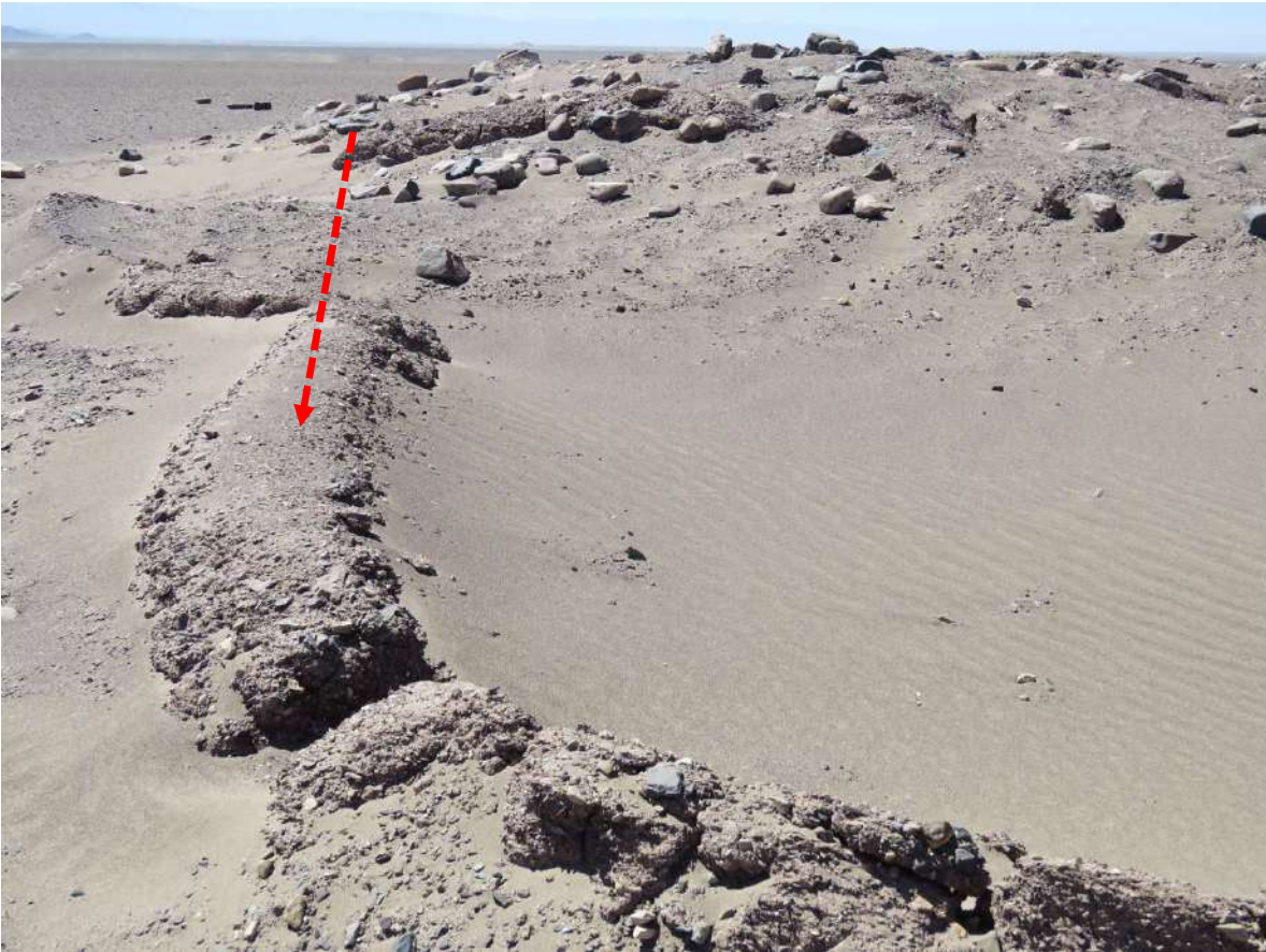
Detalle de un muro en conglomerado 2 con un alto grado de deterioro y desintegración. Nótese el estado de sepultación del recinto.
