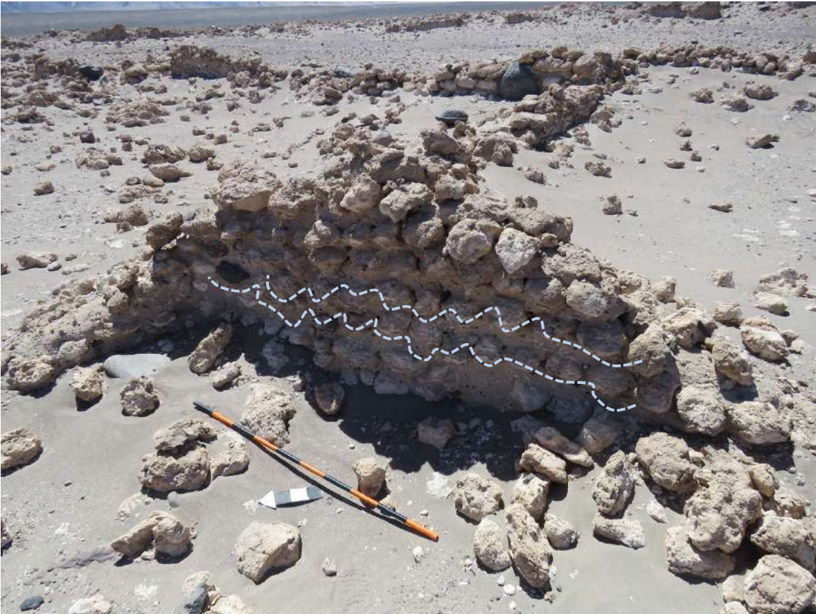
Muestra del proceso de desprendimiento paulatino de la argamasa debido a la acción eólica abrasiva en sector del Conglomerado 3.
