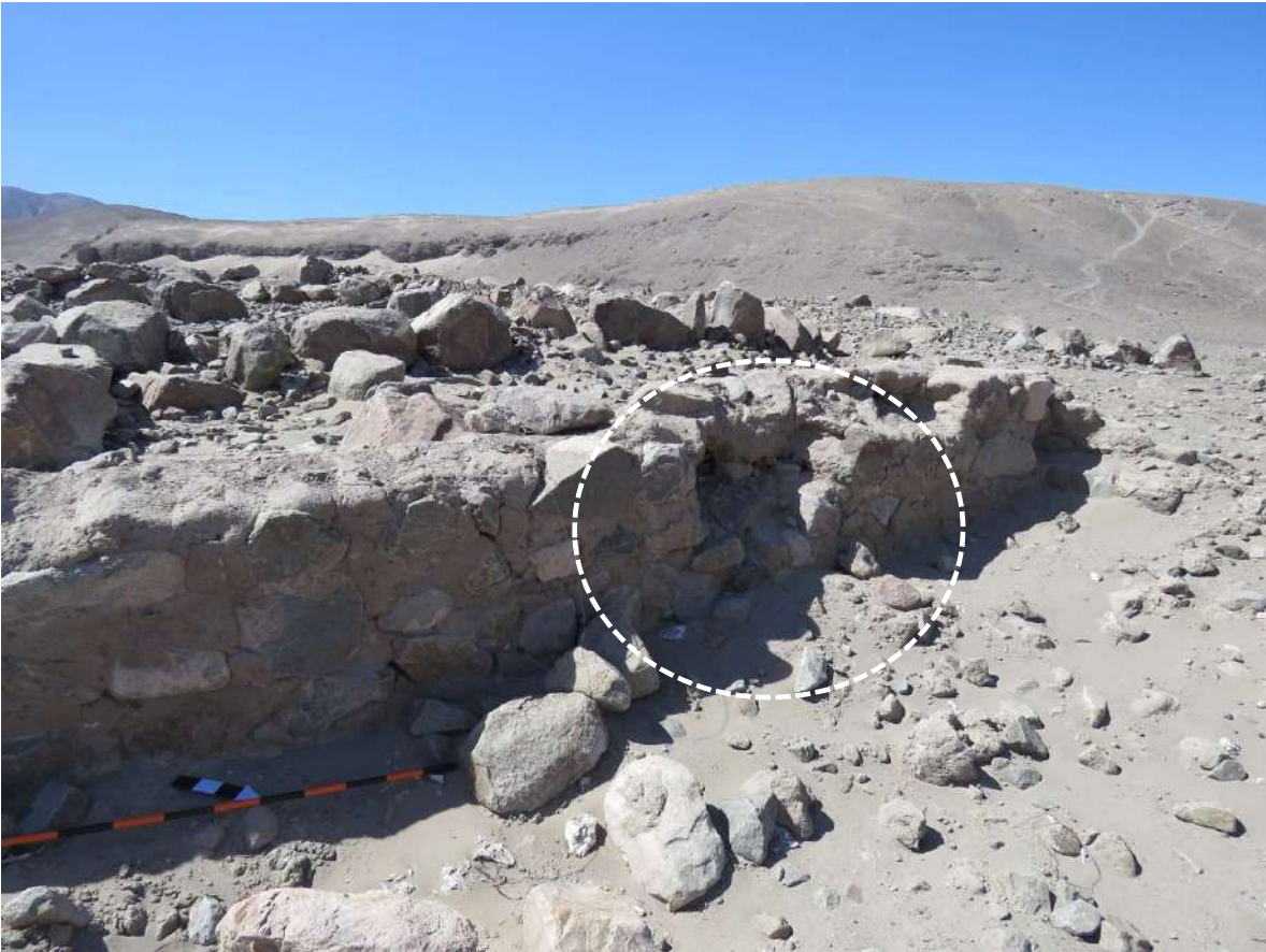
Detalle de muro con desprendimiento y faltantes de piedras.
