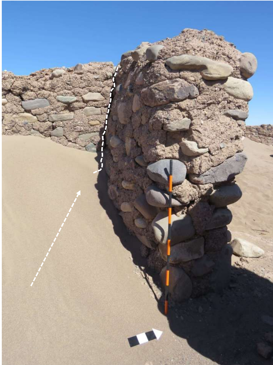
Muro Oeste entre recinto 3 y 4. La arena ejerce presión sobre el muro con vano, produciéndose una separación en la unión de ambos parapetos. Presenta fracturas diagonales en ambos muros.
