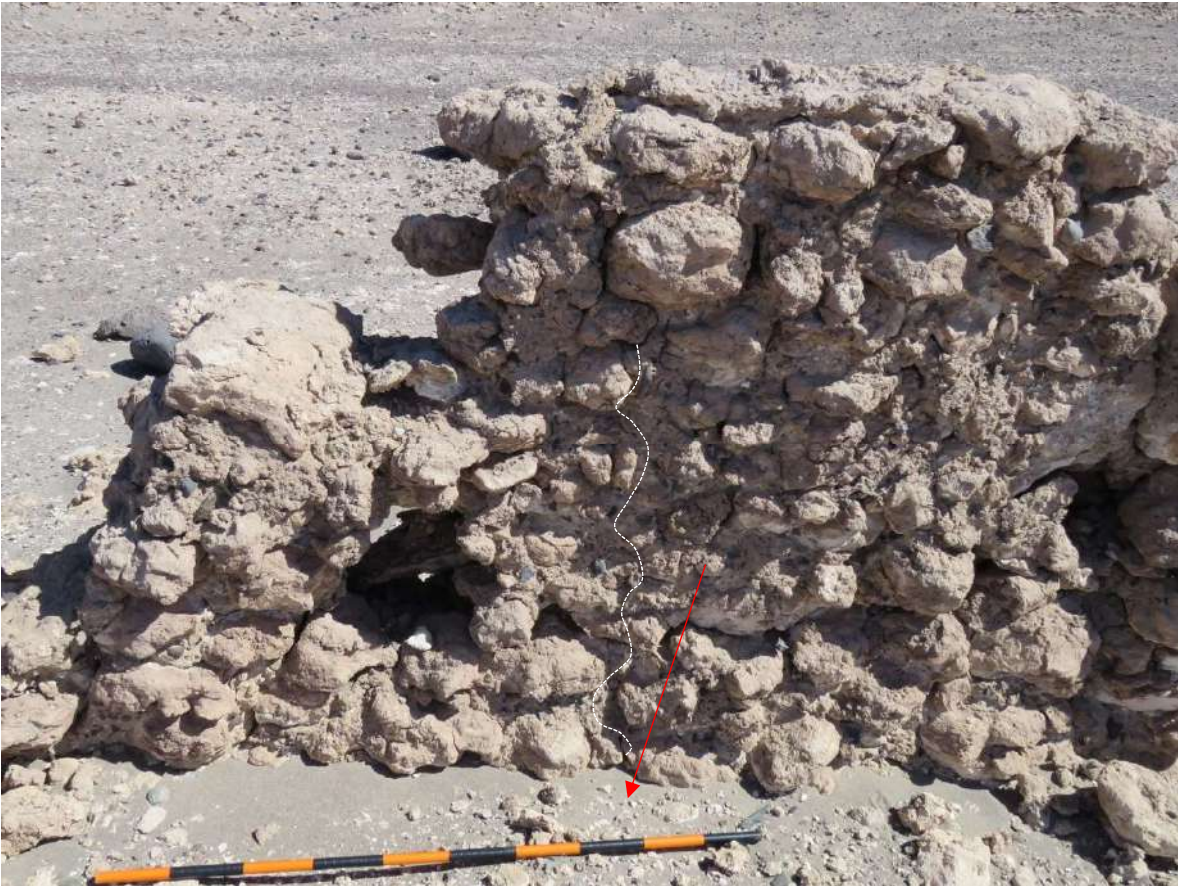
Proceso de desprendimiento paulatino de la argamasa debido a la acción eólica abrasiva en sector próximo a muro perimetral.
