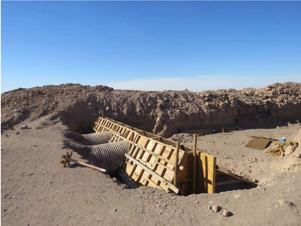
Mejoras en la zona de acceso al camino hacia la quebrada de Maní. Instalación de tubos para la canalización y evacuación del agua caída durante el invierno altiplánico.
