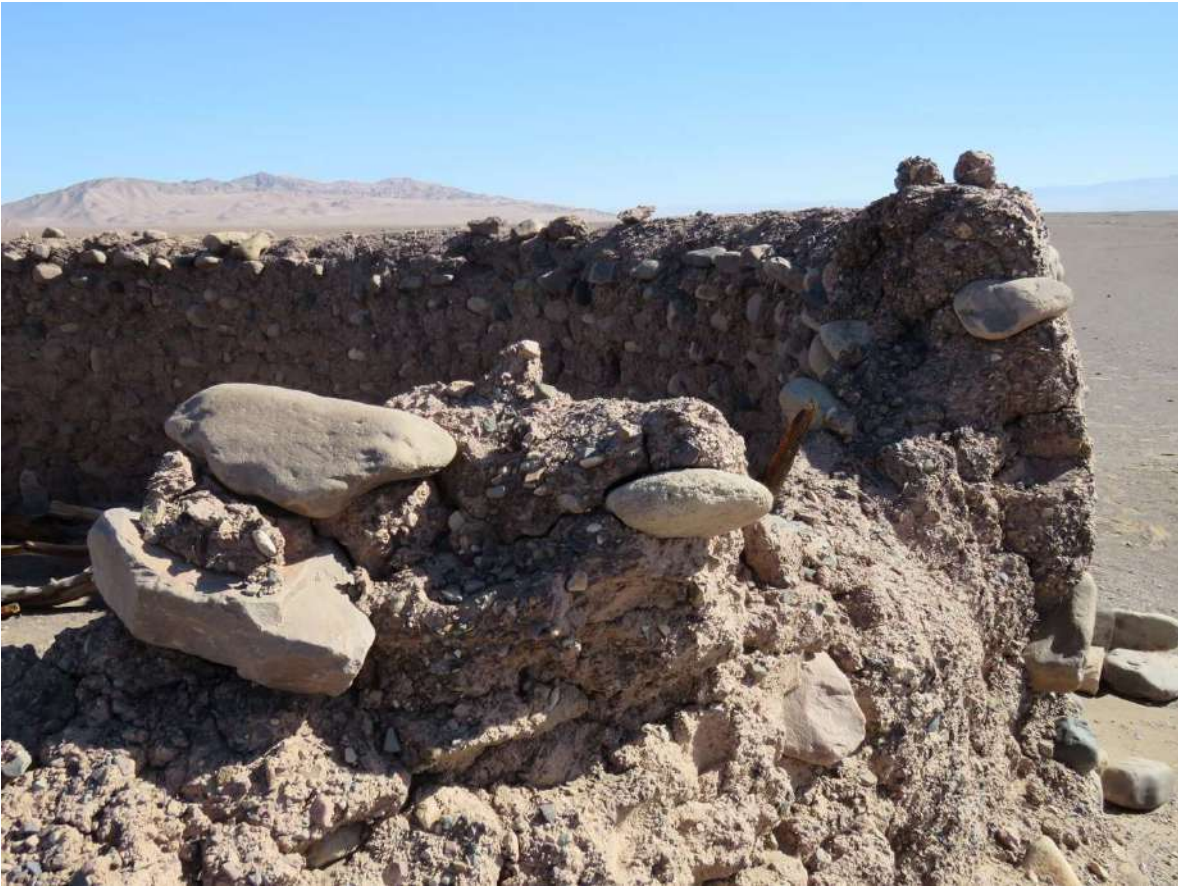
Recinto 5: Vista (b). Detalle del desprendimiento de rocas y argamasa en el muro Sureste.
