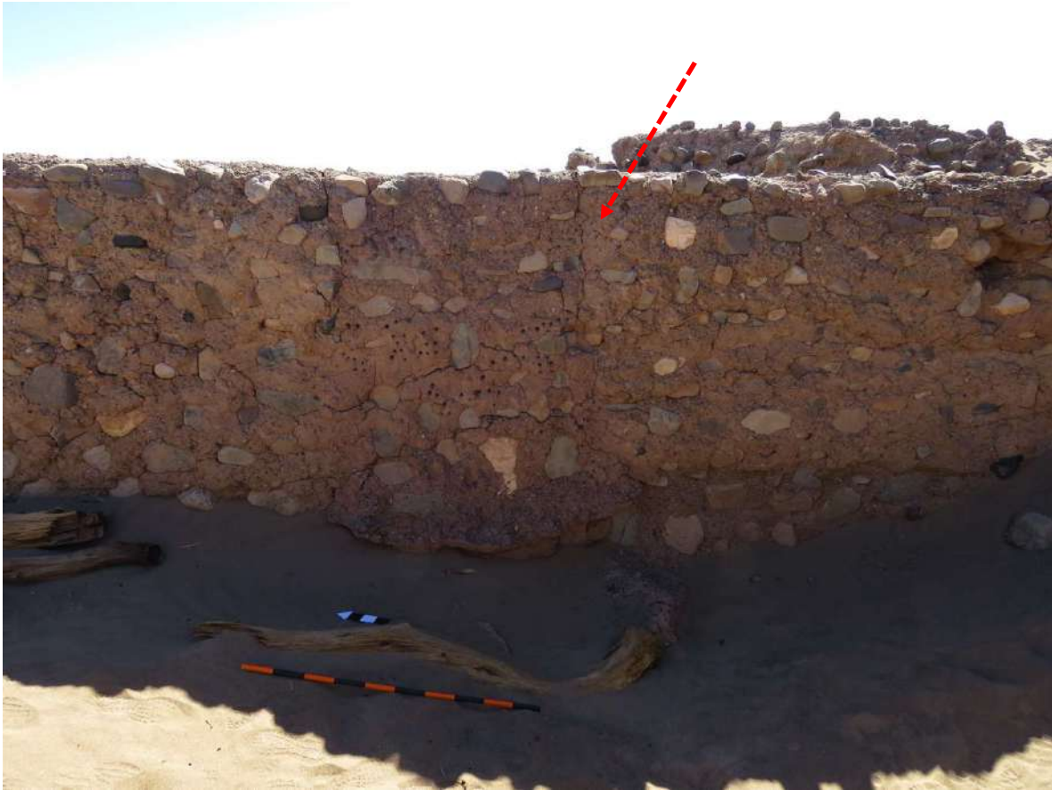
Recinto 3: Vista (a). Muro este con escasa arena. Se encuentra en buen estado de conservación. Se advierten algunas grietas ubicadas en el área de los grabados de puntos en bajo relieve.
