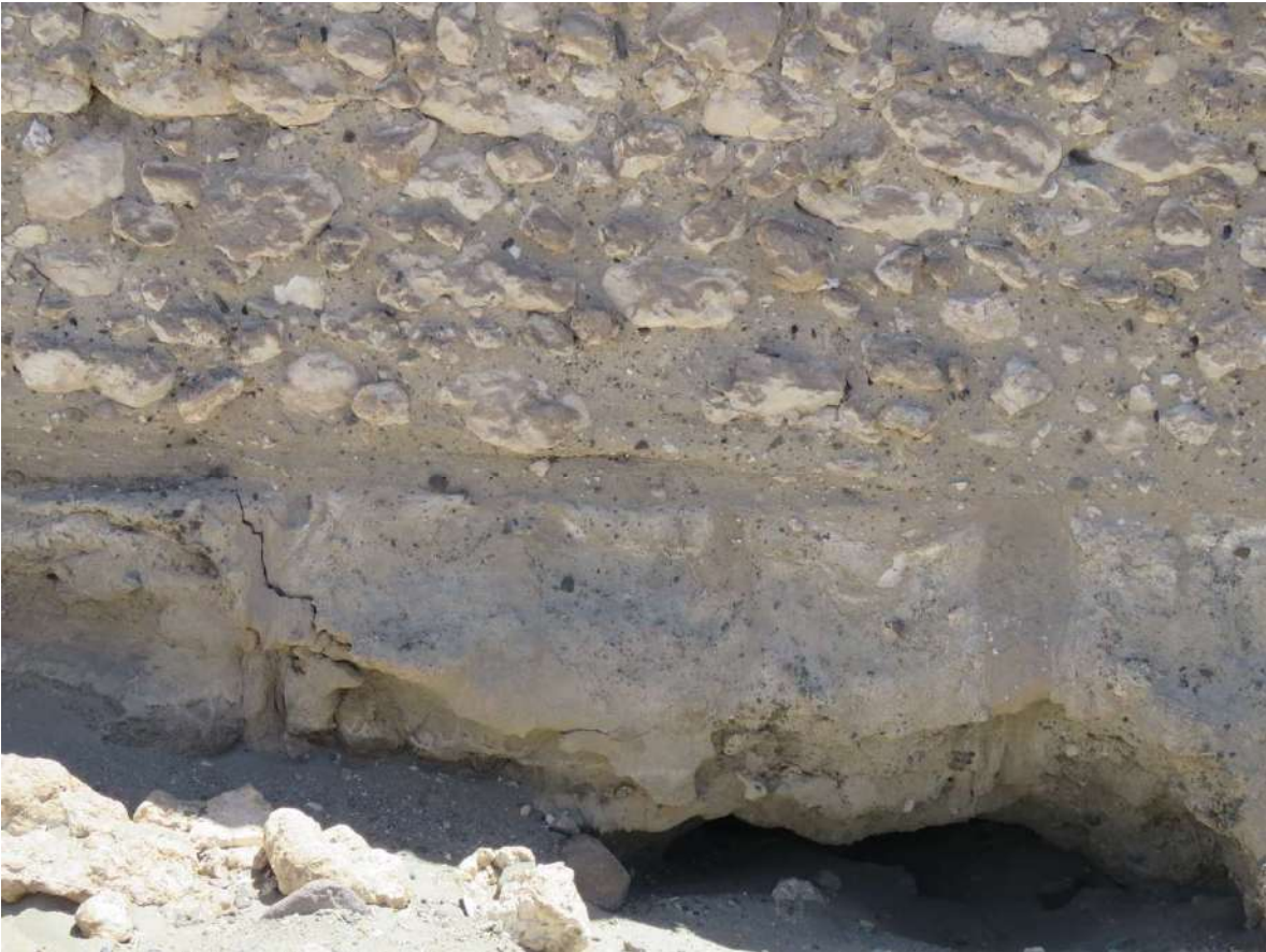
Detalle del recinto 314 (plaza), con una trinchera excavada arqueológicamente que hoy deja un socavón en la base de un muro.
