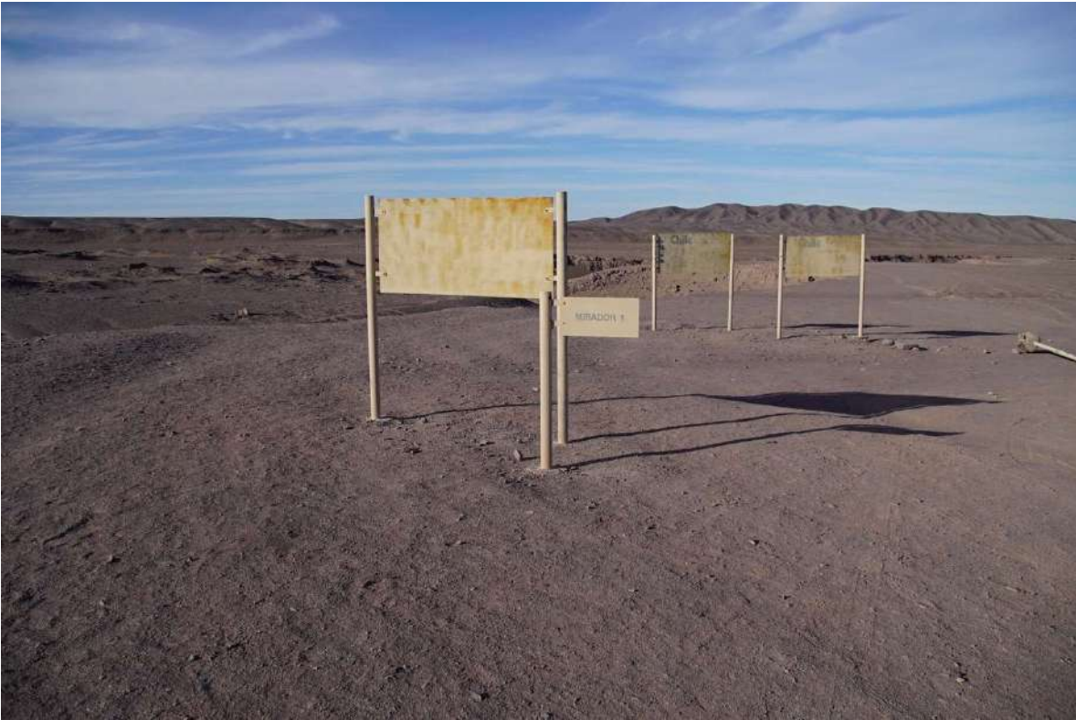
Señalética instalada en la década de 1990, hoy ilegibles producto de la radiación.
