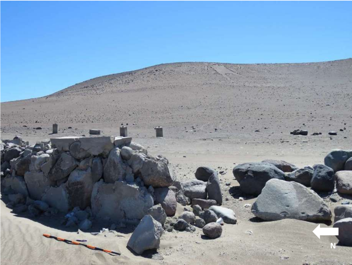
Desprendimiento de rocas desde el muro perimetral inconcluso ubicado frente al geoglifo principal.
