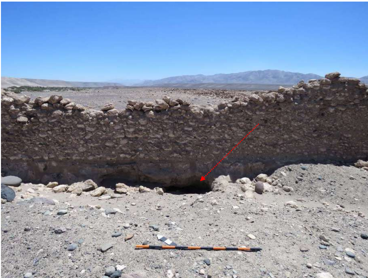
Vista general del recinto 314 (plaza), con una trinchera excavada arqueológicamente que hoy deja un socavón en la base de un muro.
