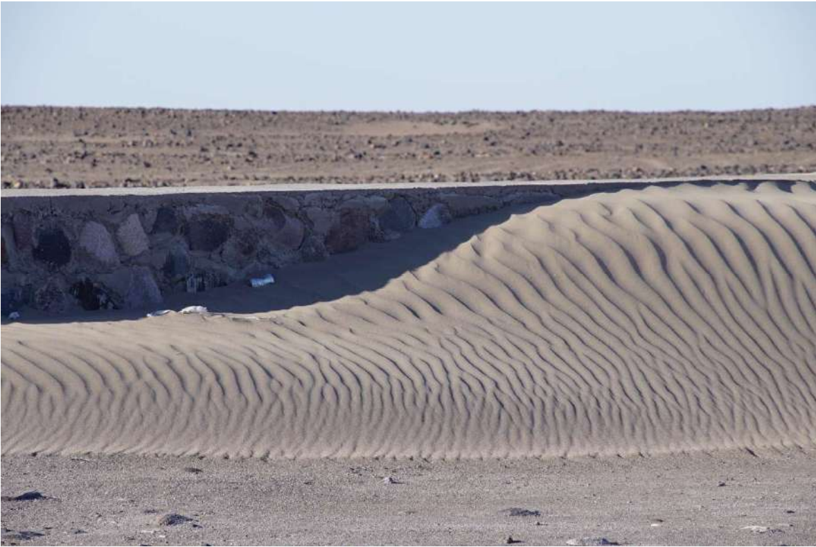
Deposición de arena en muros del abandonado e inconcluso cierre perimetral.
