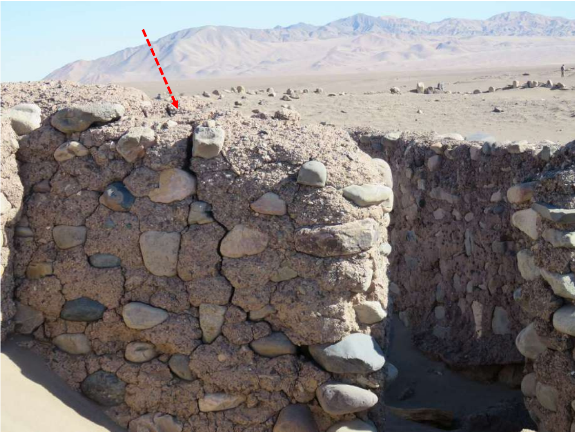
Recinto 4: Vista (b). Detalle del vano fracturado con grieta lineal vertical. Imagen tomada desde el interior del recinto.
