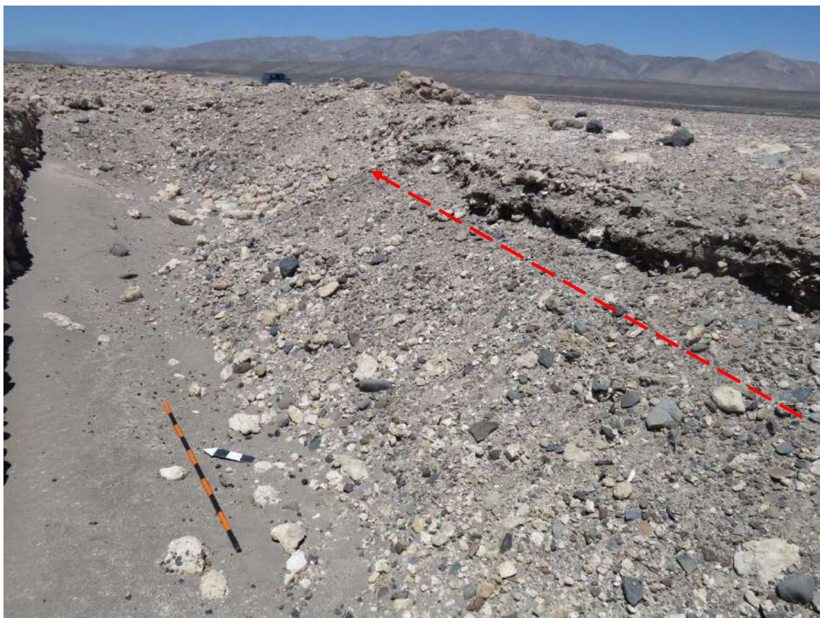
Segmento del muro perimetral derrumbado. Vista de oeste a este, próximo al Conglomerado 3.
