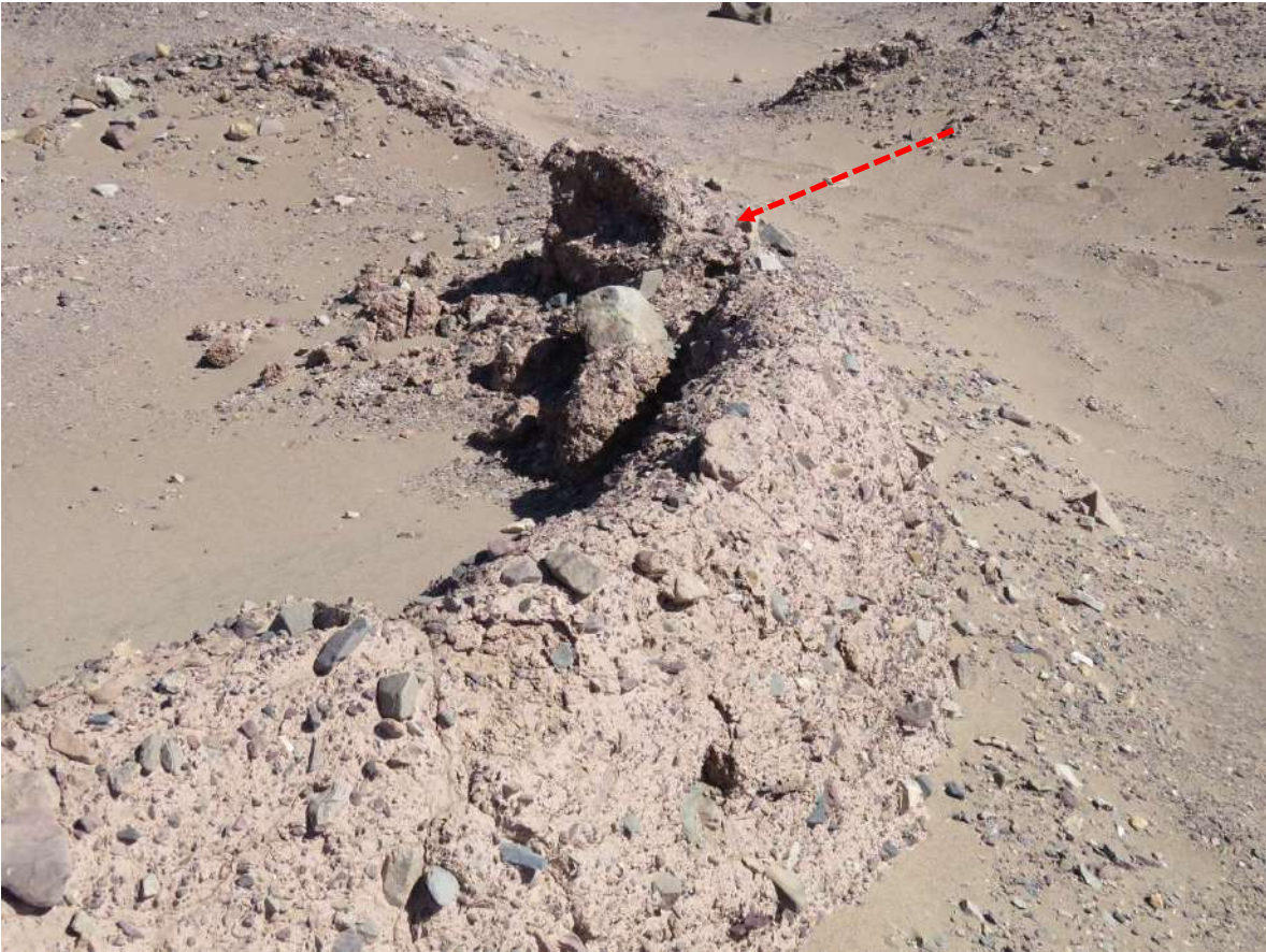
Estructura 157 ubicada en el conglomerado norte. Se observa el desprendimiento de una de las rocas ubicada en la corona de muro.
