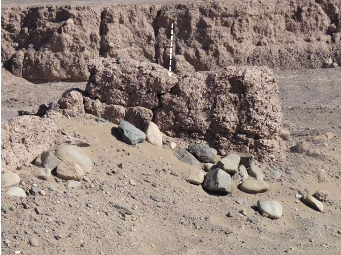
Segmento de muro estructura 110 o 113 con fractura y disgregación de sus componentes constructivos.
