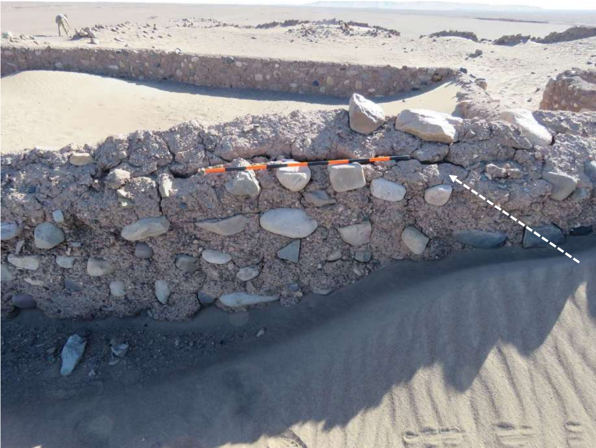
Recinto 2 y 3: Vista (a) del muro exterior oeste. Presenta fractura lineal horizontal en la cabeza del parapeto.
