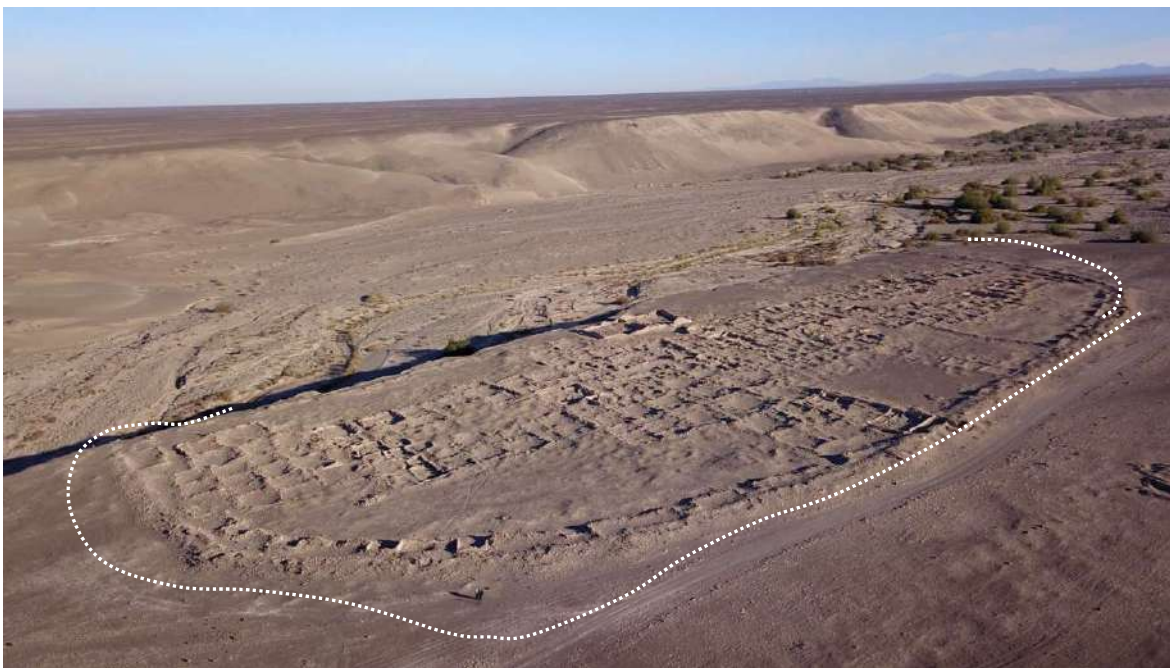
Camino vehicular informal alrededor del sitio. Fuente: Registro UBO, 1 de diciembre del 2018.
